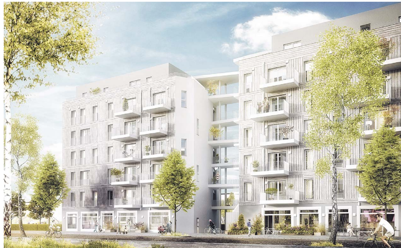
Mietshaus aus Holz in Berlin: Sogar der Aufzugsschacht im Gebäude in der Lynarstraße kommt ohne Beton aus.
